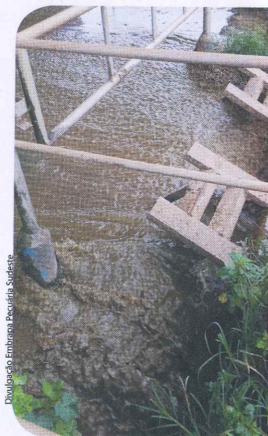
Sistema de fertirrigação na Fazenda Agrindus
