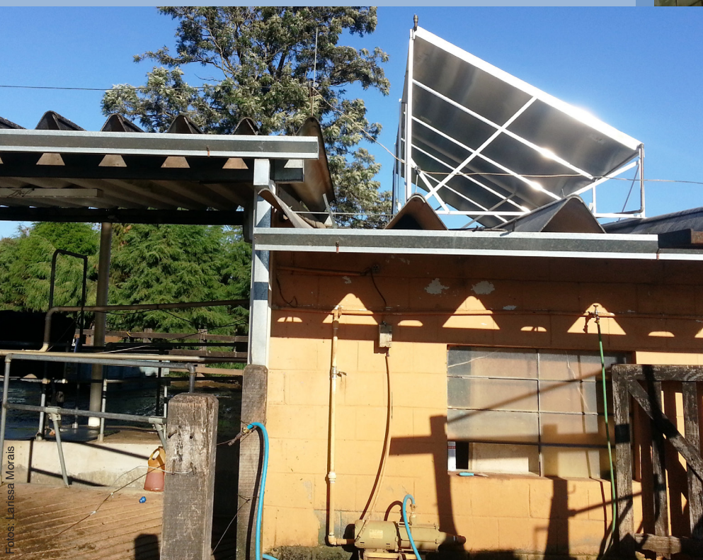
Acima, o equipamento que armazena a água. À esquerda, as placas coletoras de energia solar.
