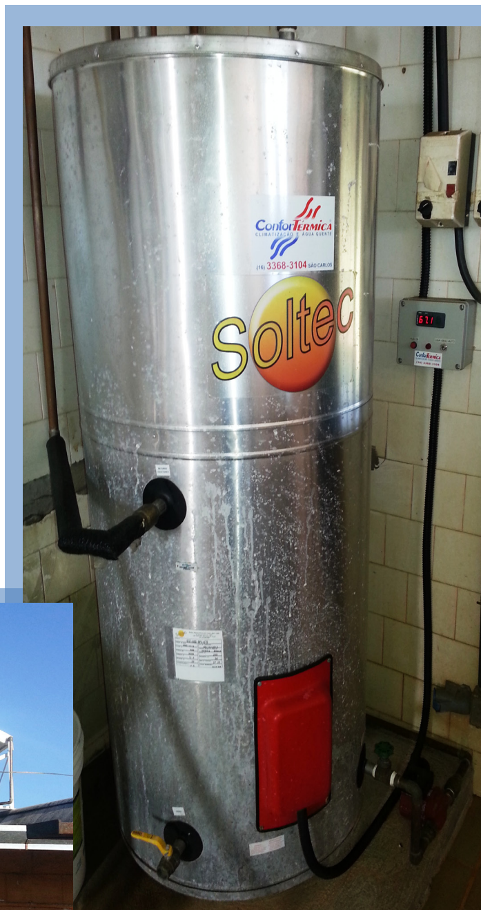
Acima, o equipamento que armazena a água. À esquerda, as placas coletoras de energia solar.
