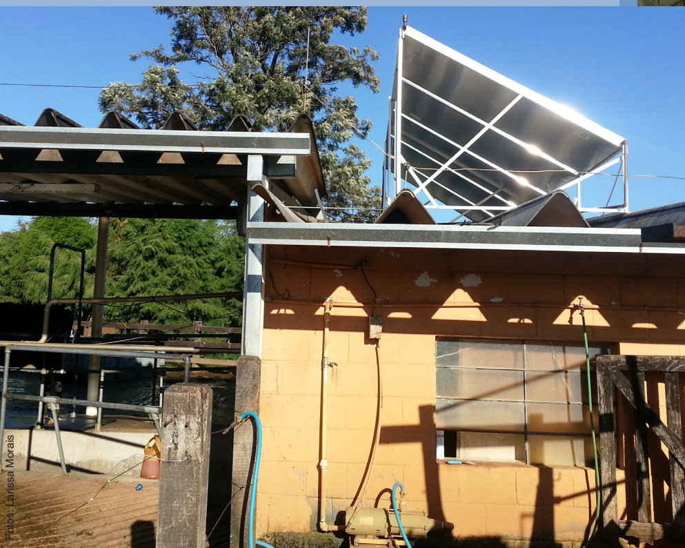
Acima, o equipamento que armazena a água. À esquerda, as placas coletoras de energia solar.
