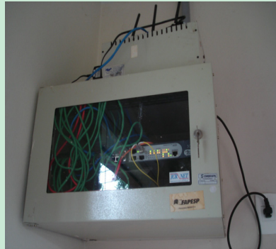
Antigo "armário" dos cabos em cada prédio
