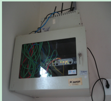
Antigo "armário" dos cabos em cada prédio
